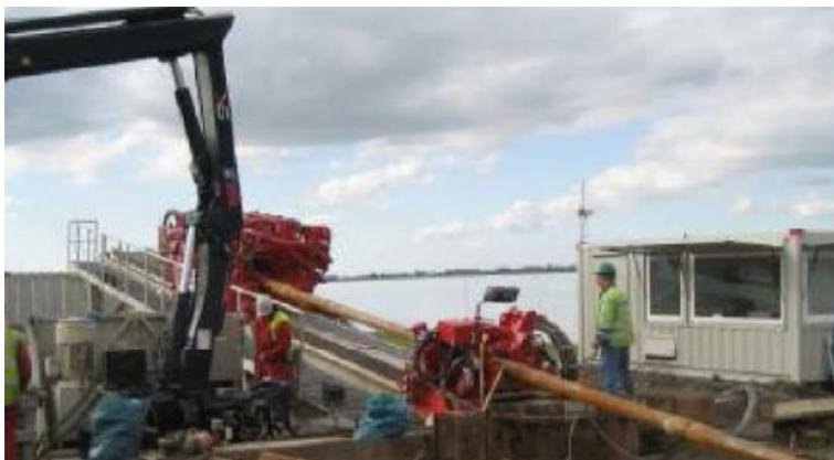
Figura 3.21: Esempio di Batteria di Tubi di Perforazione da 6 5/8"
