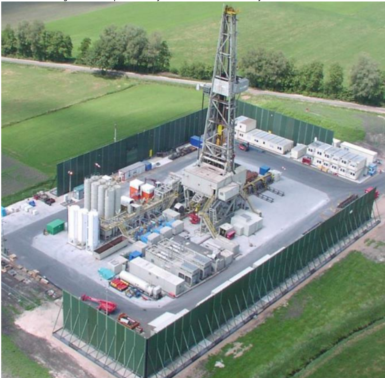
Figura 7 – Esempio barriera fonoisolante installata a confine area di cantiere
