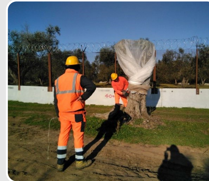
Abbattimenti Xylella Fase 1
