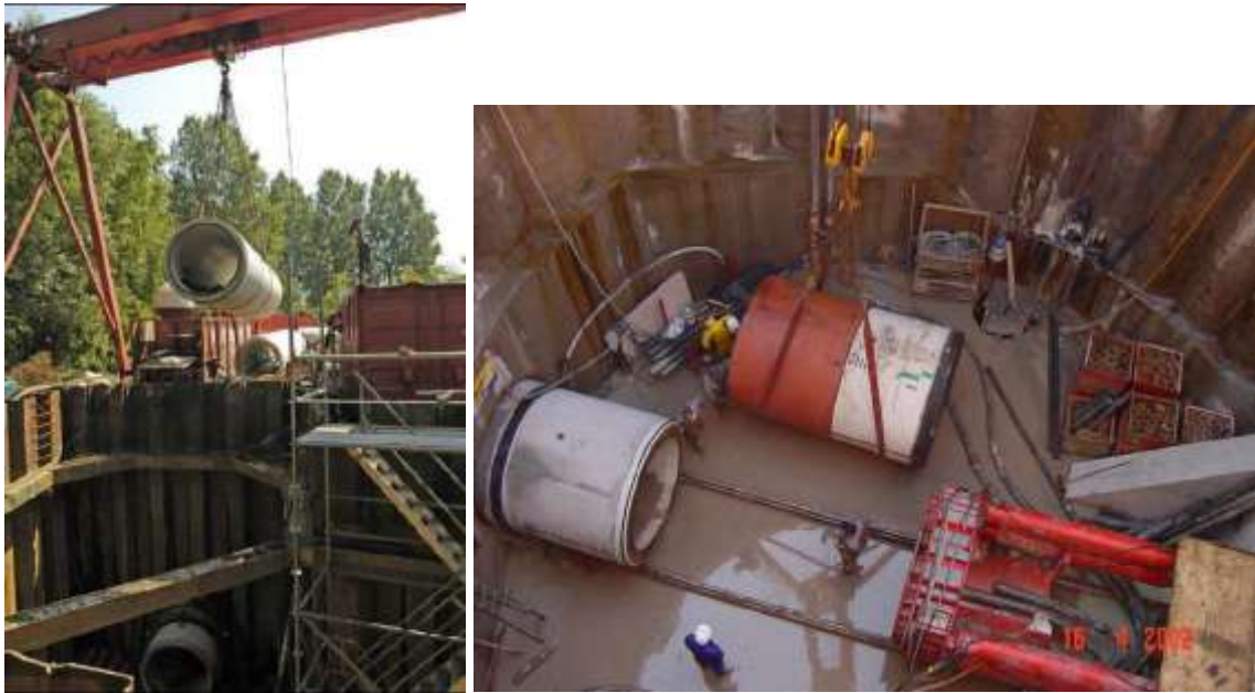
Figura 5-4: -Installazione conci
