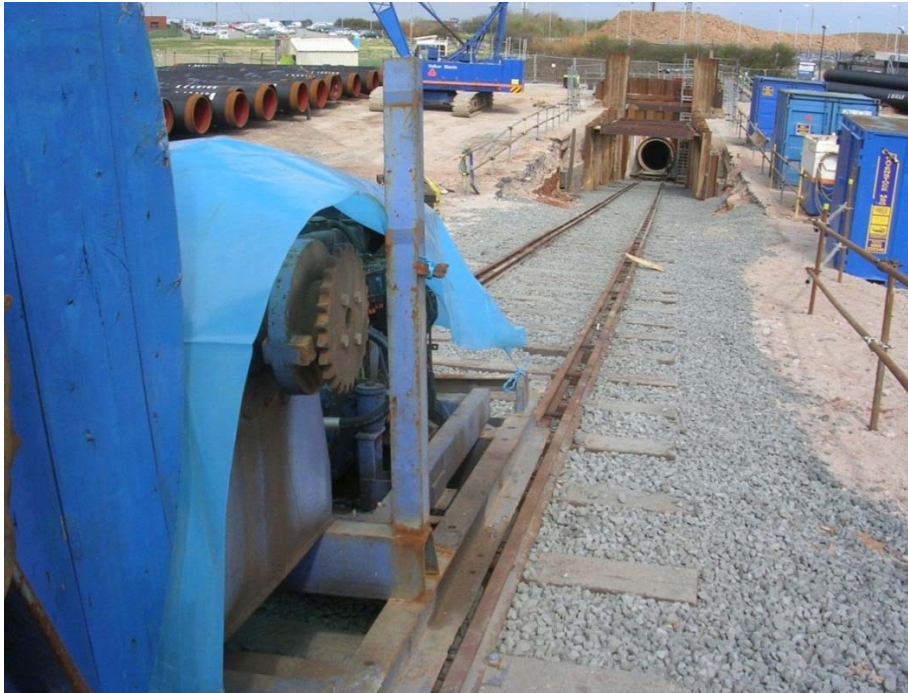
Figura 5-20: Foto di un collegamento tra argano e cavo di tiro realizzato nel punto di ingresso del microtunnel
