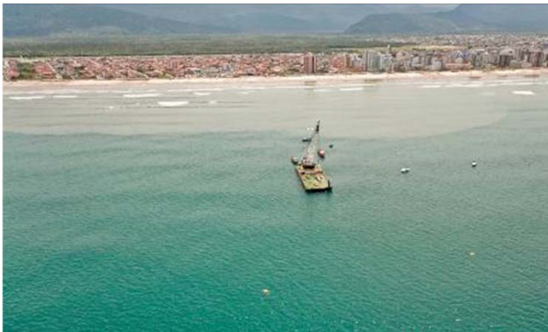
Figura 5-14: Sequenza di disegni e foto relativi ai lavori eseguiti per il recupero di un TBM e per il suo trasporto verso il porto più vicino.
