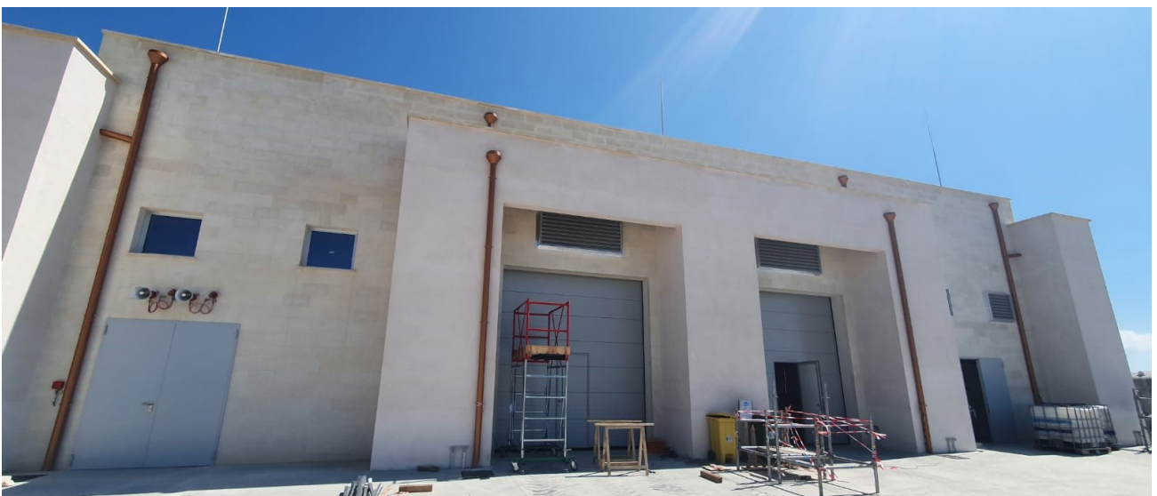
Figura 3.6 - Stato dei luoghi PRT – Area Edifici luglio 2020
