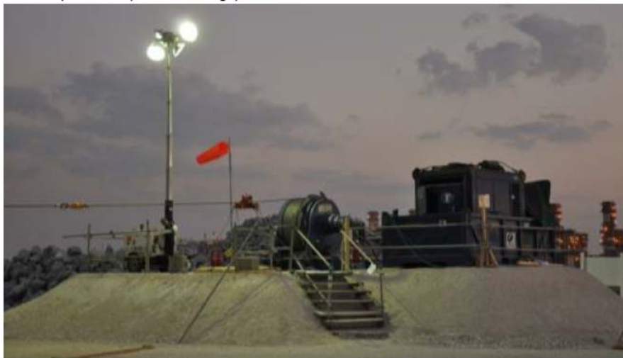
Figura 13-1: Tipico verricello per il tiro del gasdotto.
