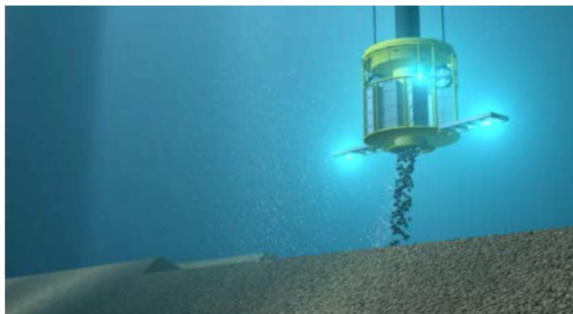
Figura 15-2 Installazione di ghiaia
