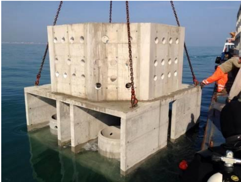
Figura 18 I materiali utilizzati per la barriera artificiale di Riccione
