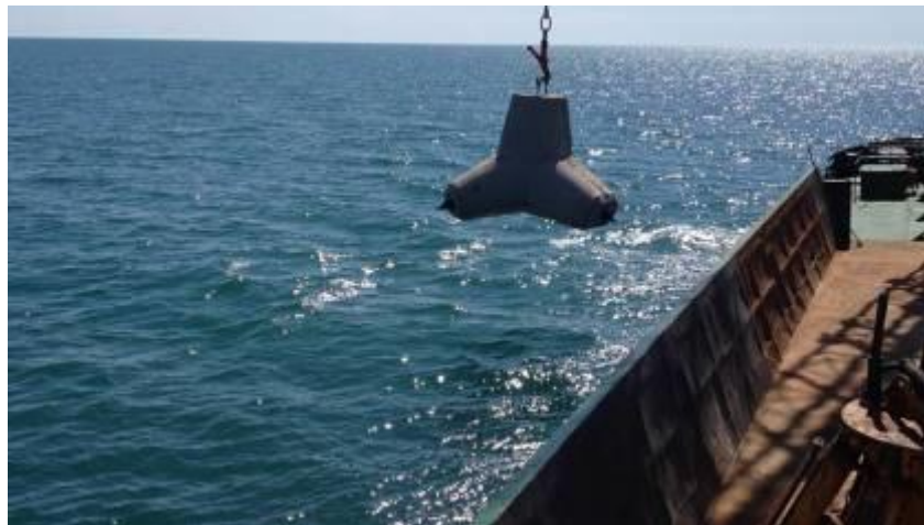
Figura 28 Le strutture antistrascico per la salvaguardia della P. oceanica posizionate tra la foce del Chiarone e Morelle (Lazio settentrionale)
