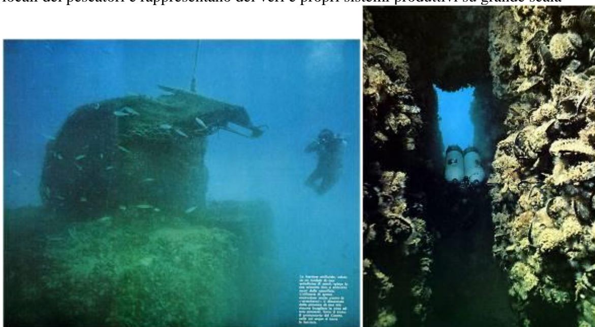
Figura 16 Effetto antistrascico delle barriere artificiali: rete rimasta impigliata su una piramide della barriera artificiale di Porto Recanati (a sinistra). Spazi tra i moduli di una barriera: è visibile la spessa copertura di mitili (a destra)
