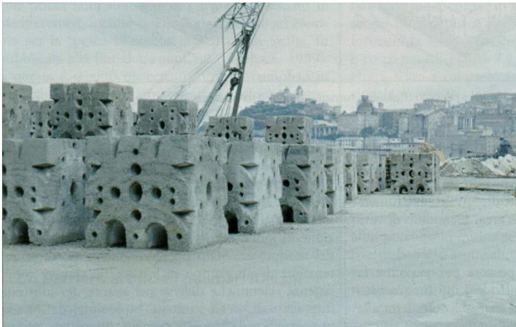
Figura 13 La struttura dei cubi in calcestruzzo impiegati per la barriera artificiale di Ancona
