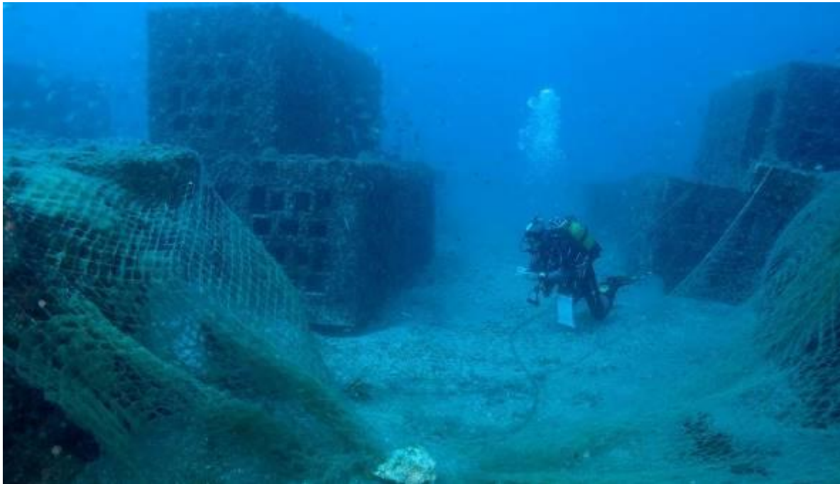
Figura 8 Strutture utilizzate in Spagna per la protezione dei fondali e l'incremento delle risorse ittiche. In primo piano è visibile una rete a strascico bloccata tra i massi
