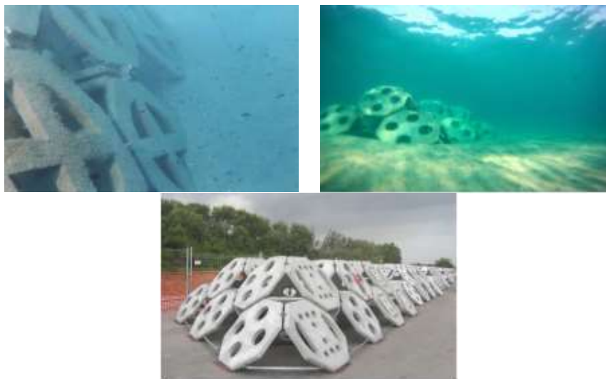
Figura 3 - Il modulo “Tecnoreef” impiegato per realizzare strutture artificiali in diverse località italiane.
