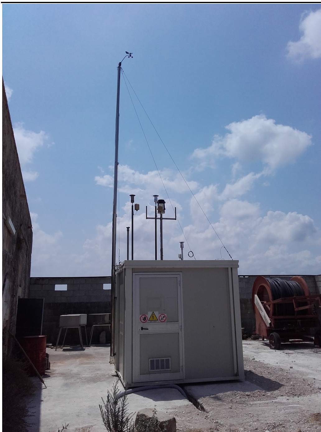
Figura 5.1 Esempio di Centralina di Monitoraggio della Qualità dell’Aria
