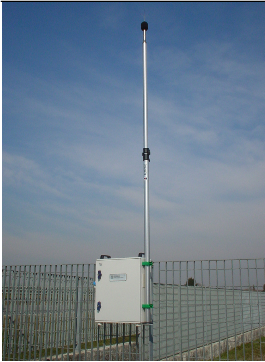
Figura 5.2 Esempio di Centralina di Monitoraggio del Rumore
