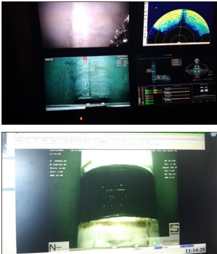
Figura 18. Monitoraggio da remoto del "varo guidato" e controllo del punto di posa della condotta.
