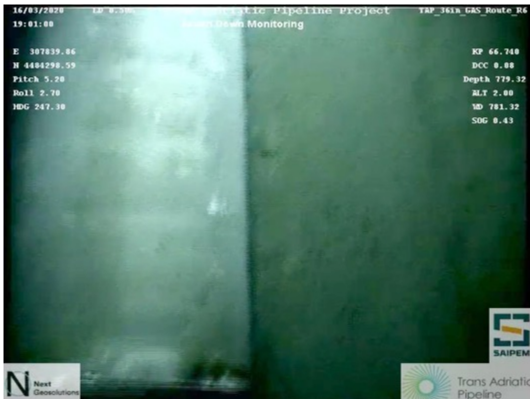
Figura 28. KP66.748, condotta posata all'interno dell'area del CF 02/2018 (Cfr. Figura 25 – Foto_03)
