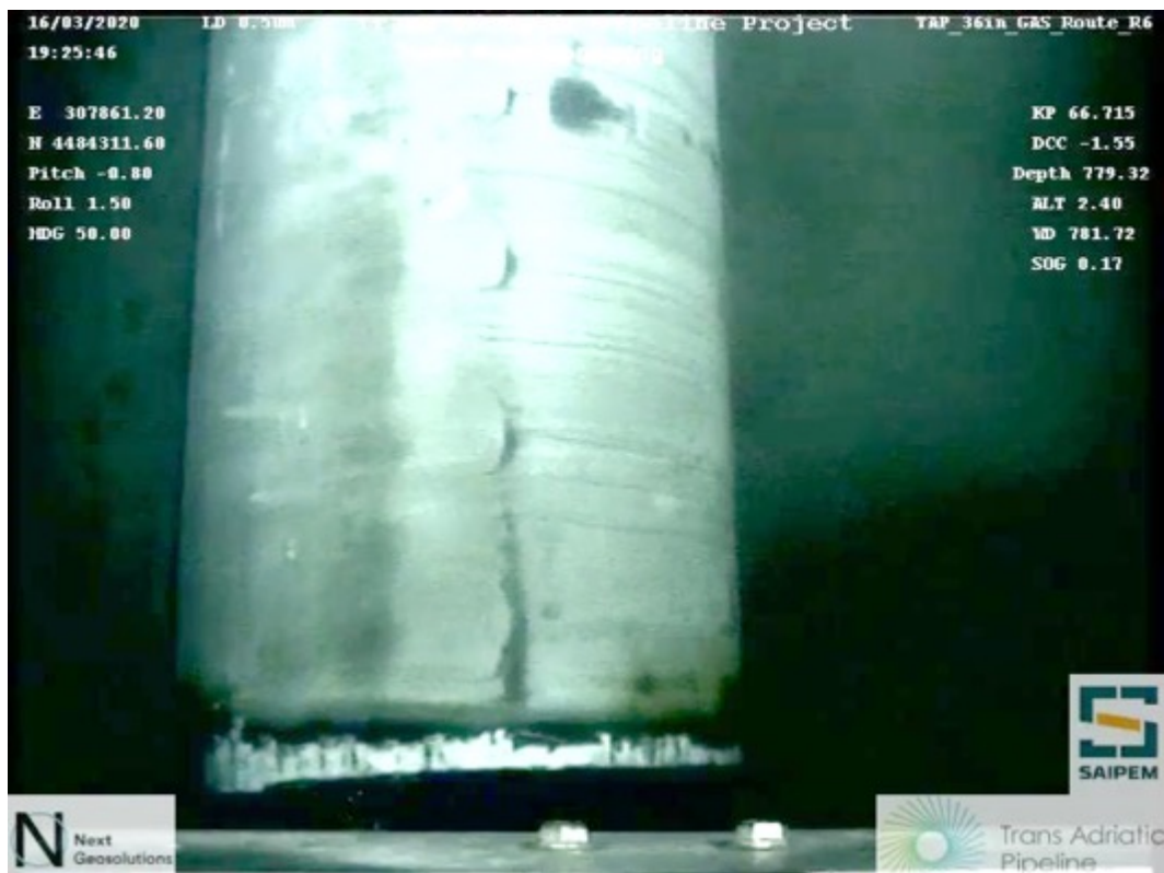
Figura 30. KP66.715, condotta posata all'interno dell'area del CF 02/2018 (Cfr. Figura 25 – Foto_05)
