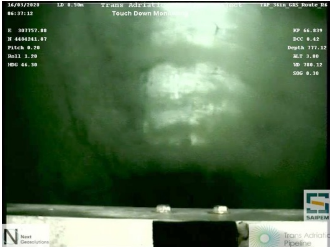
Figura 26. KP66.839, fase di posa della condotta all'esterno dell'area del CF 02/2018 (Cfr. Figura 25 – Foto_01)
