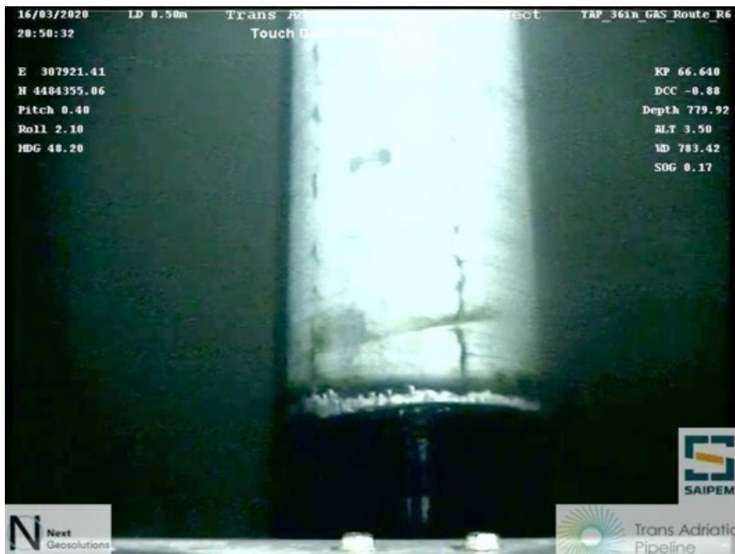
Figura 34. KP66.640, condotta posata immediatamente all'esterno dell'area del CF 02/2018 (Cfr. Figura 25 – Foto_09)
