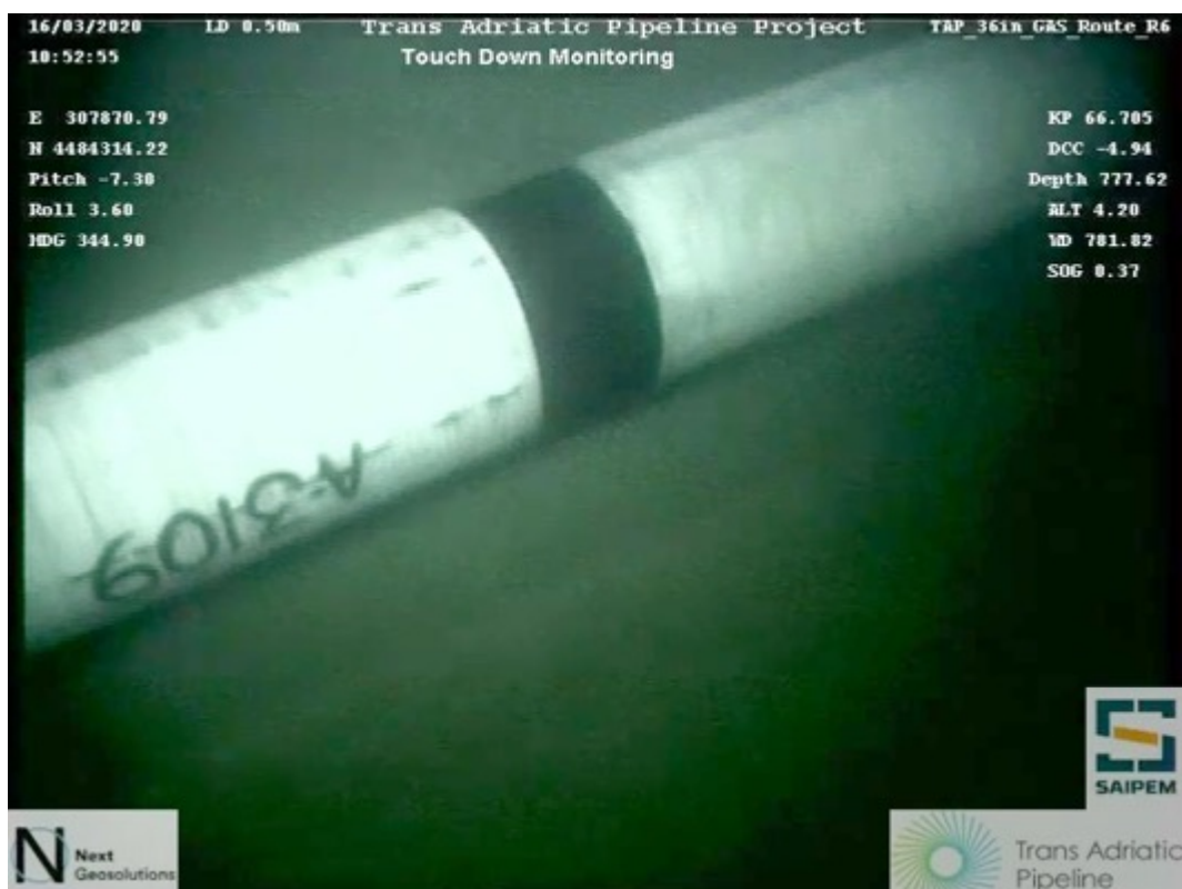
Figura 31. KP66.705, condotta posata all'interno dell'area del CF 02/2018 (Cfr. Figura 25 – Foto_06)
