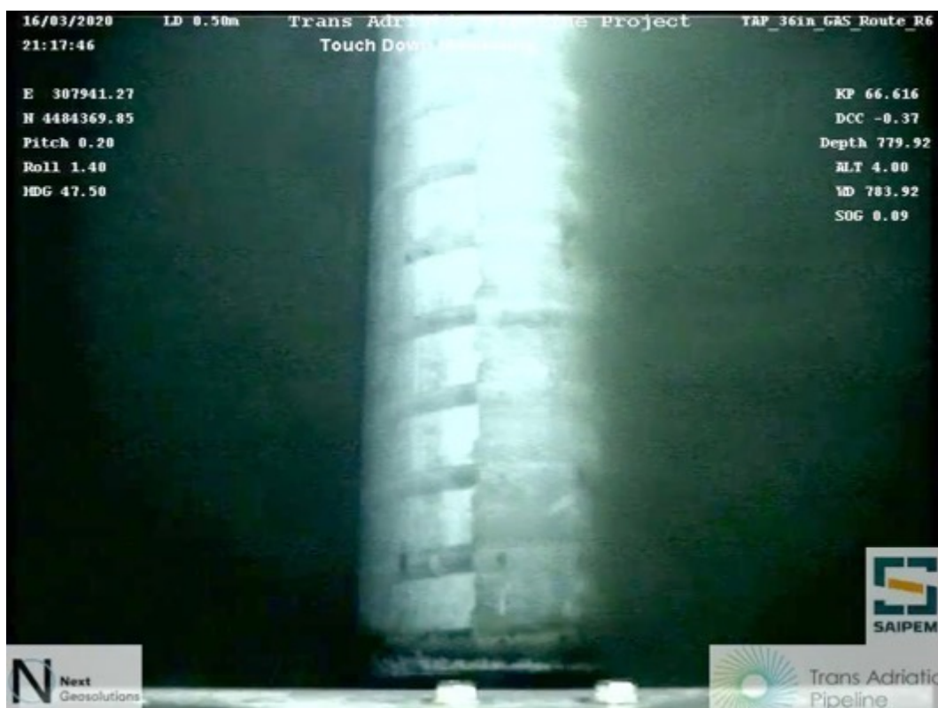
Figura 35. KP66.616, condotta posata all'esterno dell'area del CF 02/ (Cfr. Figura 25 – Foto_10)
