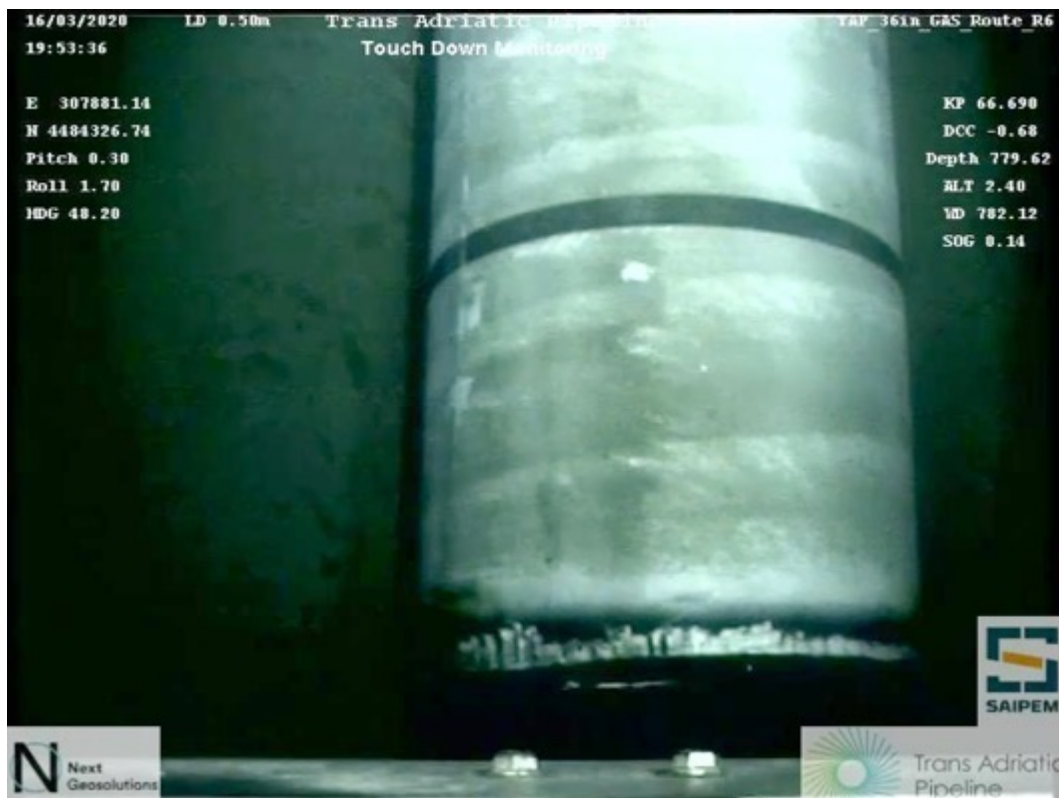
Figura 32. KP66.690, condotta posata all'interno dell'area del CF 02/2018 (Cfr. Figura 25 – Foto_07)
