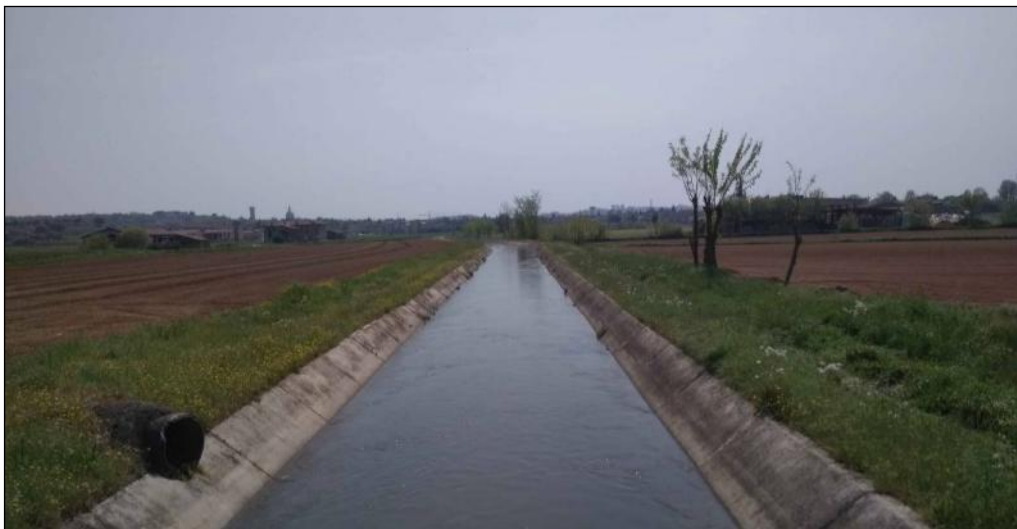
Figura 5.10.13 - Roggia Lonata AV-LO-FA-21. Vista della roggia verso valle nell'aprile 2018
