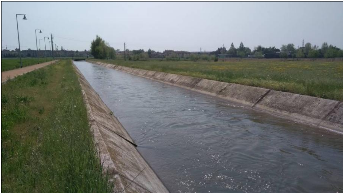
Figura 3.1.35 - Particolare dell'area di indagine AV-LO-FA-21_R.Lonata
