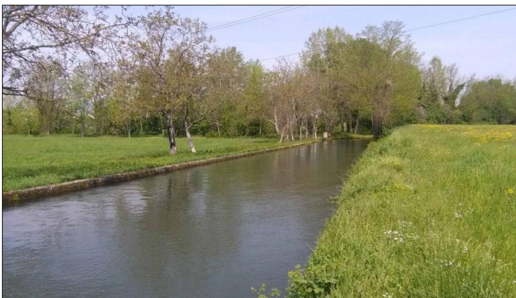
Figura 5.10.12 - Roggia Maggiore AV-CA-FA-20. Vista della roggia verso monte nell'aprile 2018
