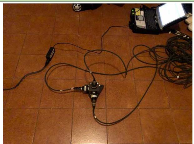
Posizionamento accelerometri monoassiali, piano primo
