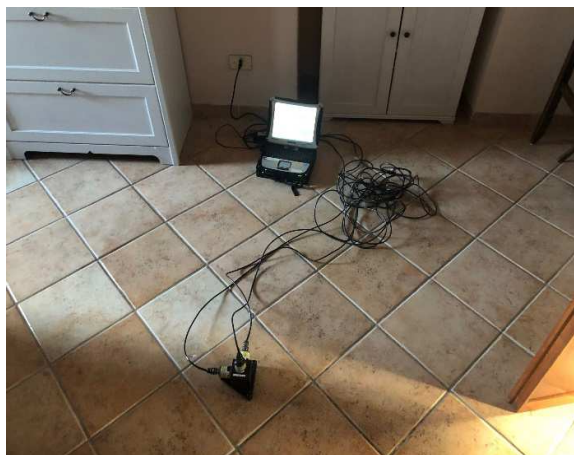
Posizionamento accelerometri monoassiali, piano terra
