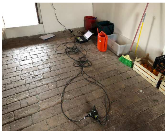
Posizionamento accelerometri monoassiali, piano primo
