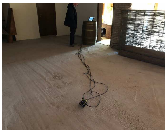
Posizionamento accelerometri monoassiali, piano primo
