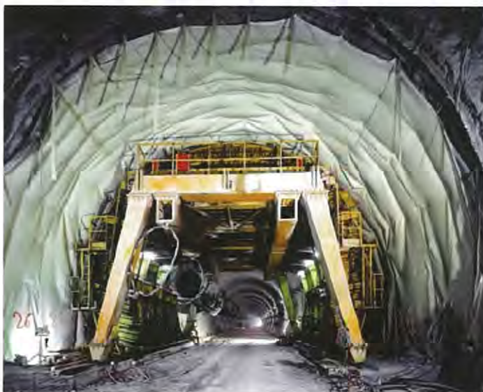
Figura 4-5 – Esempio di interventi di impermeabilizzazione.
