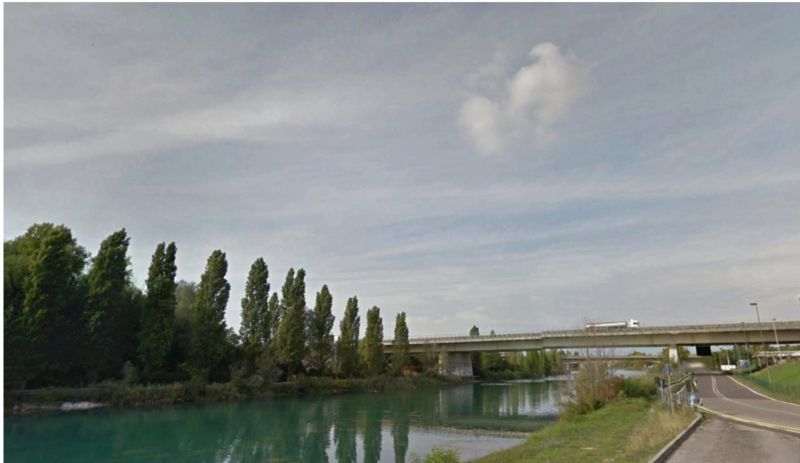
Foto 3: vista verso nord del fiume Mincio in corrispondenza del punto ove verrà realizzato in nuovo viadotto
