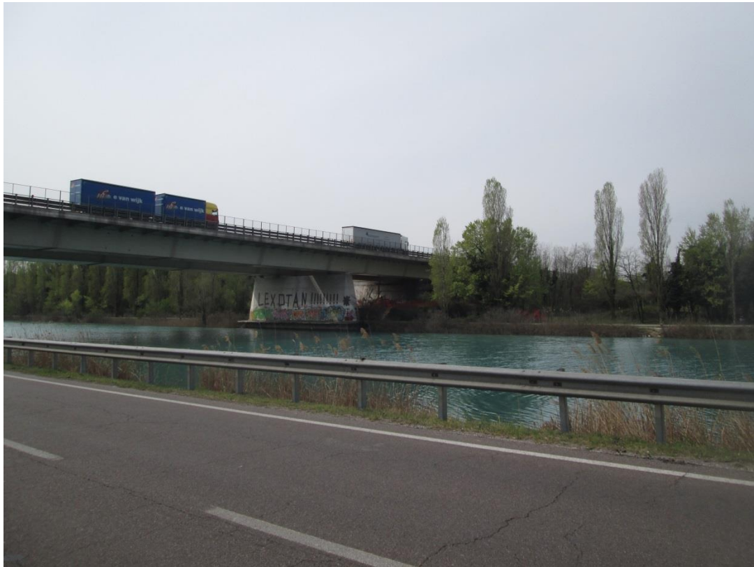
Foto 7: vista di dettaglio dl viadotto autostradale al quale si affiancherà quello ferroviario in progetto
