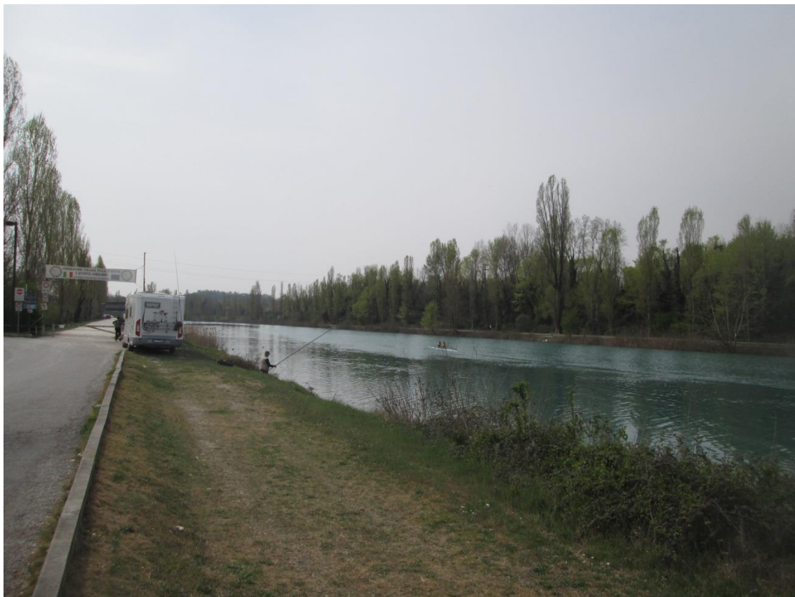
Foto 4: vista verso sud dl corso del fiume Mincio alle spalle dell'area interessata dal passaggio dl viadotto
