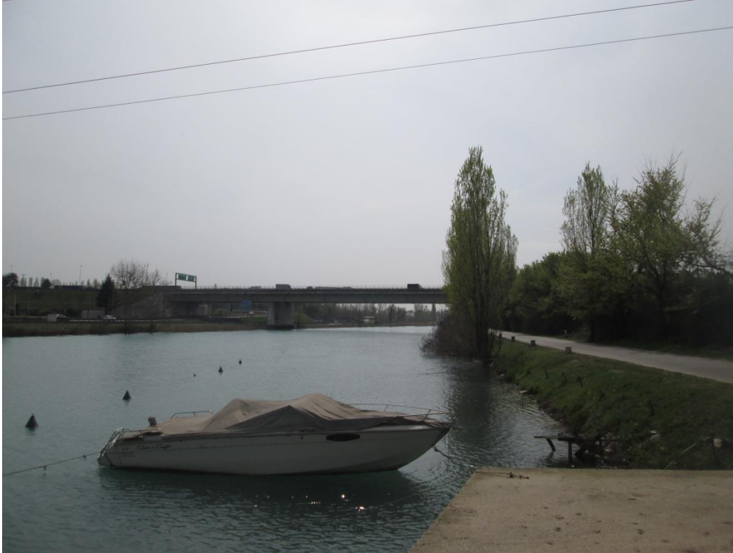
Foto 11: vista dalla ciclovía Mantova-Peschiera, sullo sfondo il viadotto autostradale oltre il quale verrà realizzato il viadotto ferroviario
