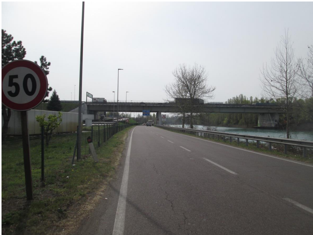
Foto 6: vista verso sud dalla SR49, sullo sfondo il viadotto dell'autostrada A4 Torino-Trieste
