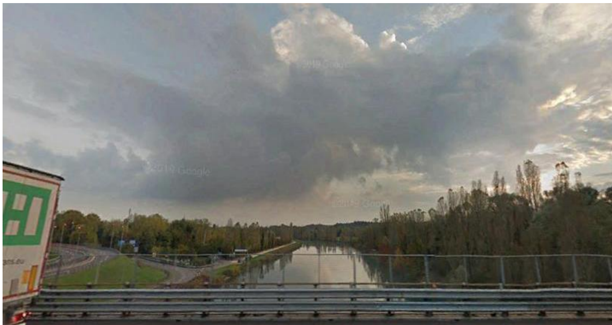
Foto 8: vista verso sud dal viadotto autostradale dell'ambito di intervento
